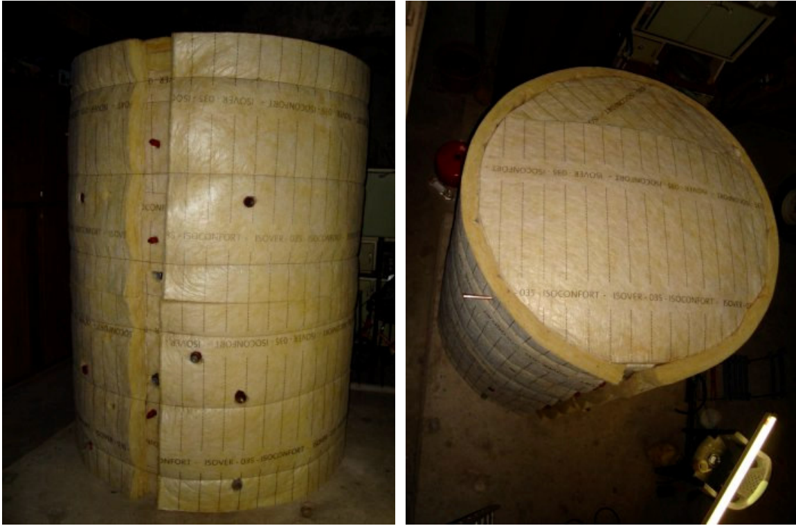
Figure 4 : isolation de l'accumulateur.
